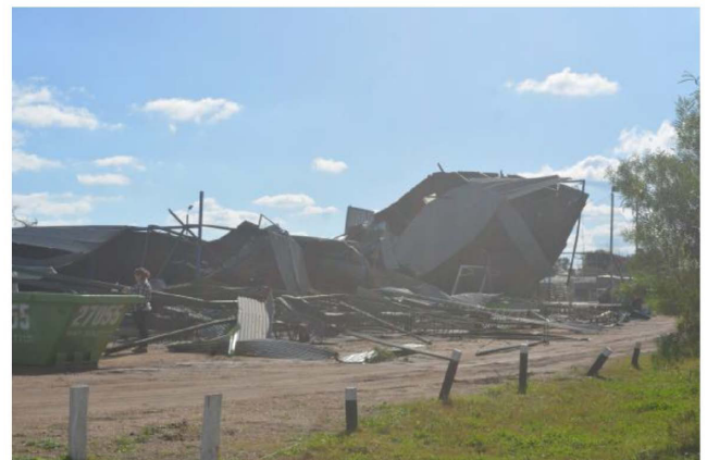
Daños en complejo deportivo de Paysandú.
