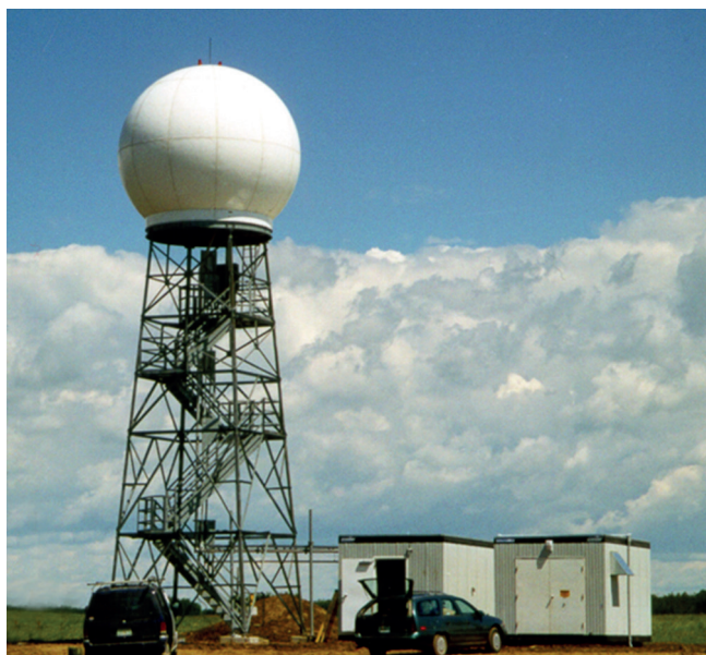
Figura 7.1. Radar meteorológico típico en una red canadiense con los principales componentes físicos de un sistema de radar. La torre es de aproximadamente 30 m de altura y dispone de un radomo con luces de señalización y pararrayos.
